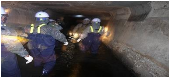
하수도 작업 현장
