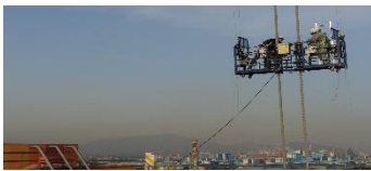
고공 작업 현장
