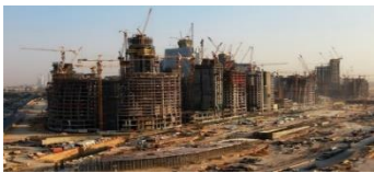
넓은 공사 현장
